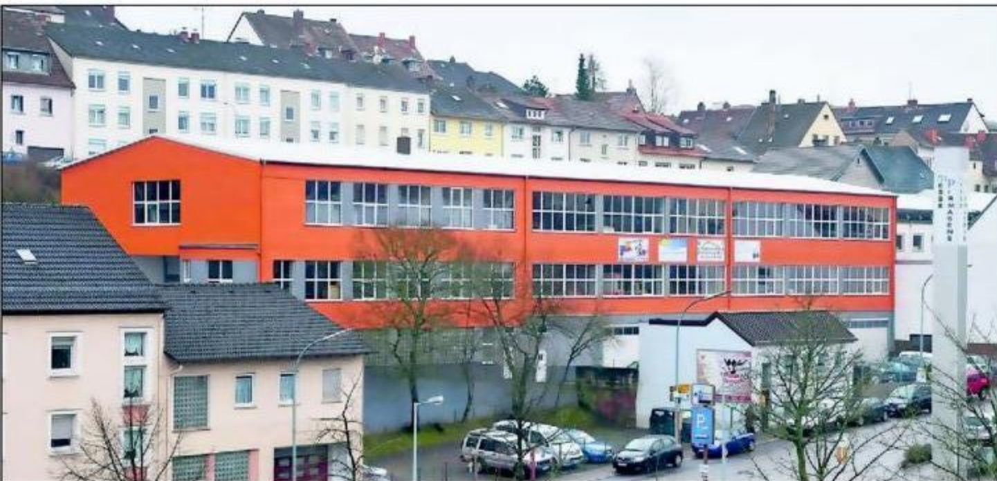
Zwischen Neuffer- und Zeppelinstraße liegt die dreigeschossige Halle.
